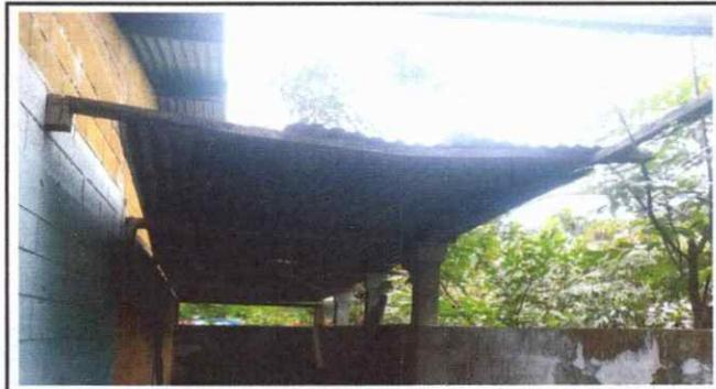
Foto 4: Cubierta de lámina y estructura a sustituir en servicios sanitarios.
